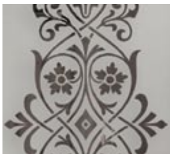
Speciale sierbeglazing middels zandstraaltechniek
